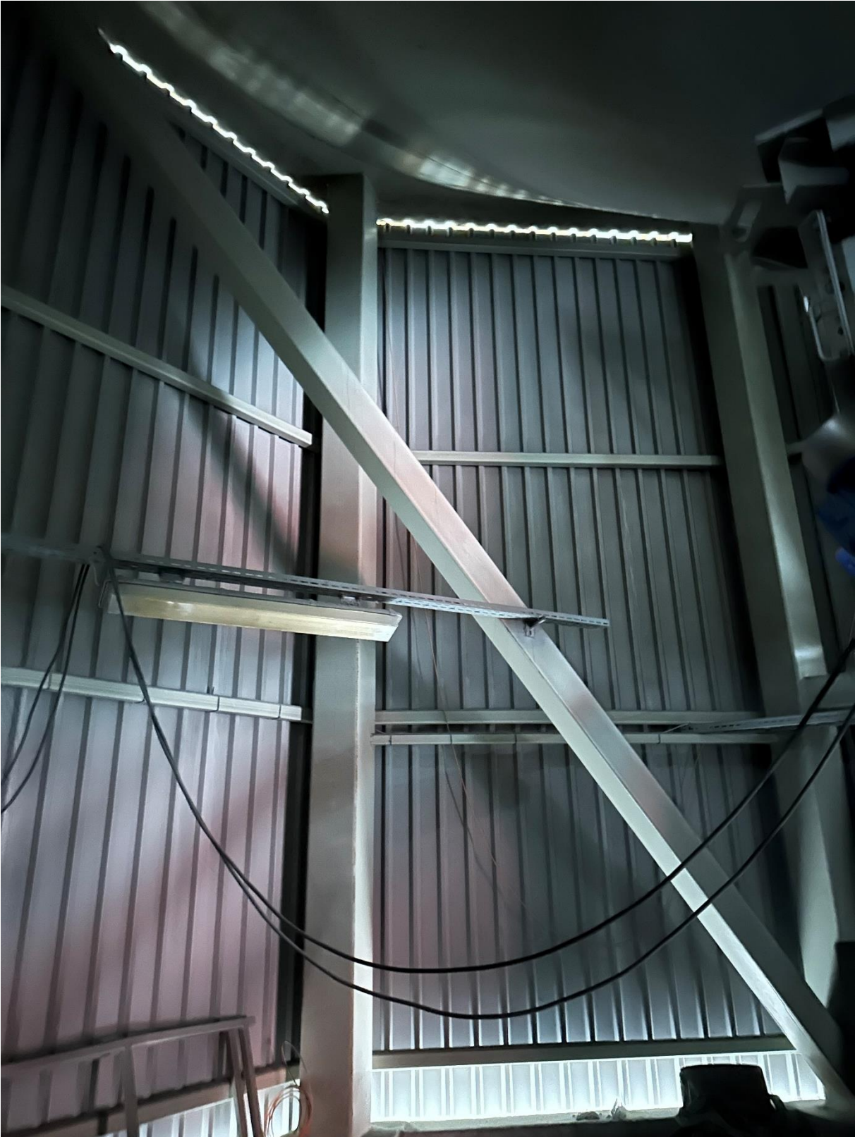
Innvendig bygg. Plater mot siloramme. Silo skjørt som leder vannet utenfor
