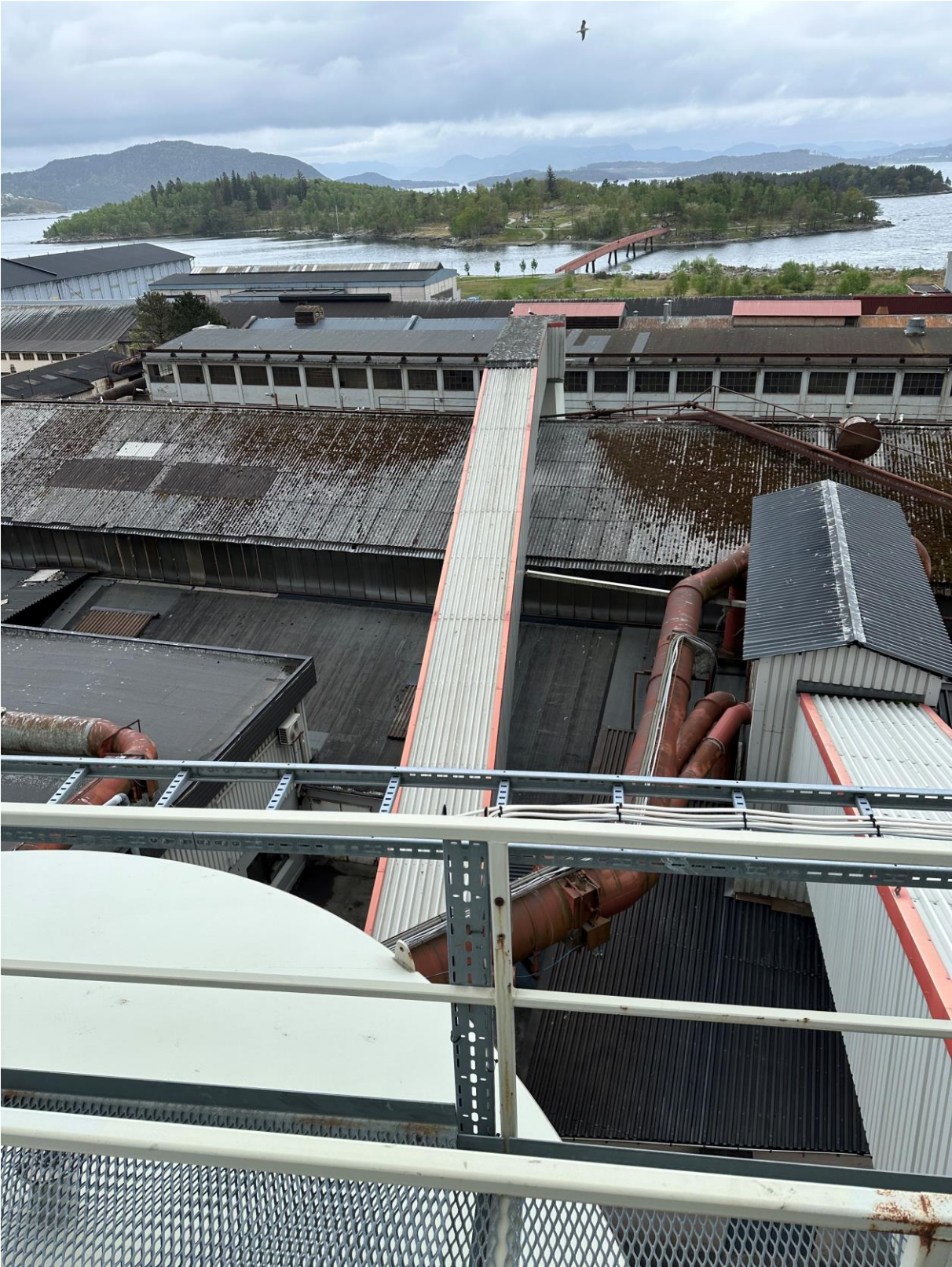
Lang fagverksbro, ca 32m
