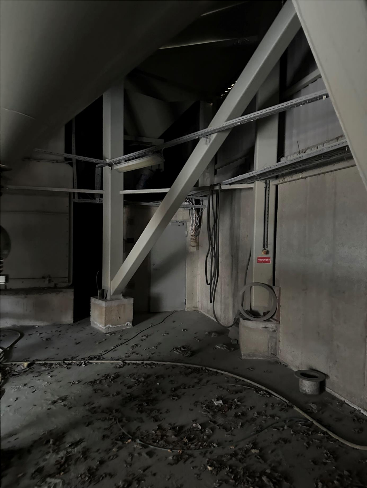
Alle siloer på frittstående ben med sveisefester
