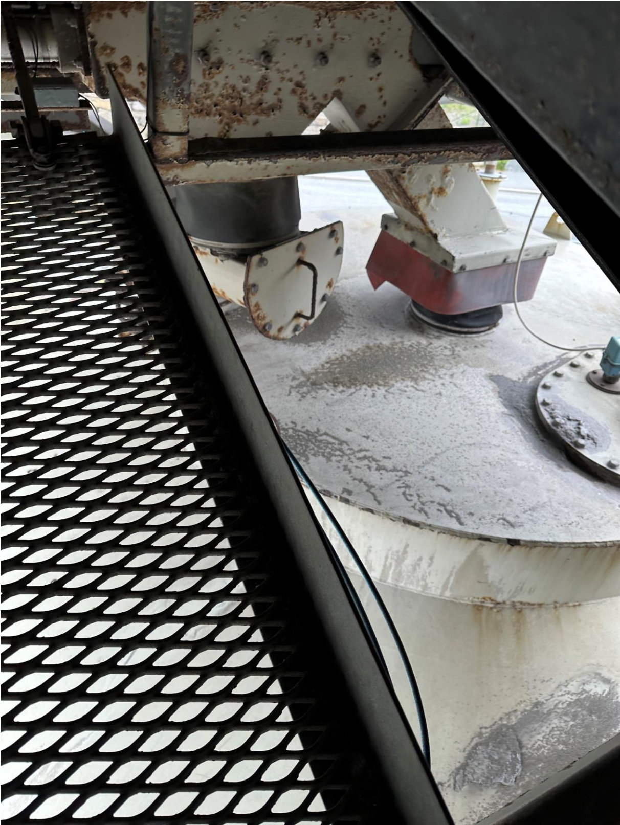
Silotop renne med ventil for rørmater. Kan styre massen i 2 stk siloer
