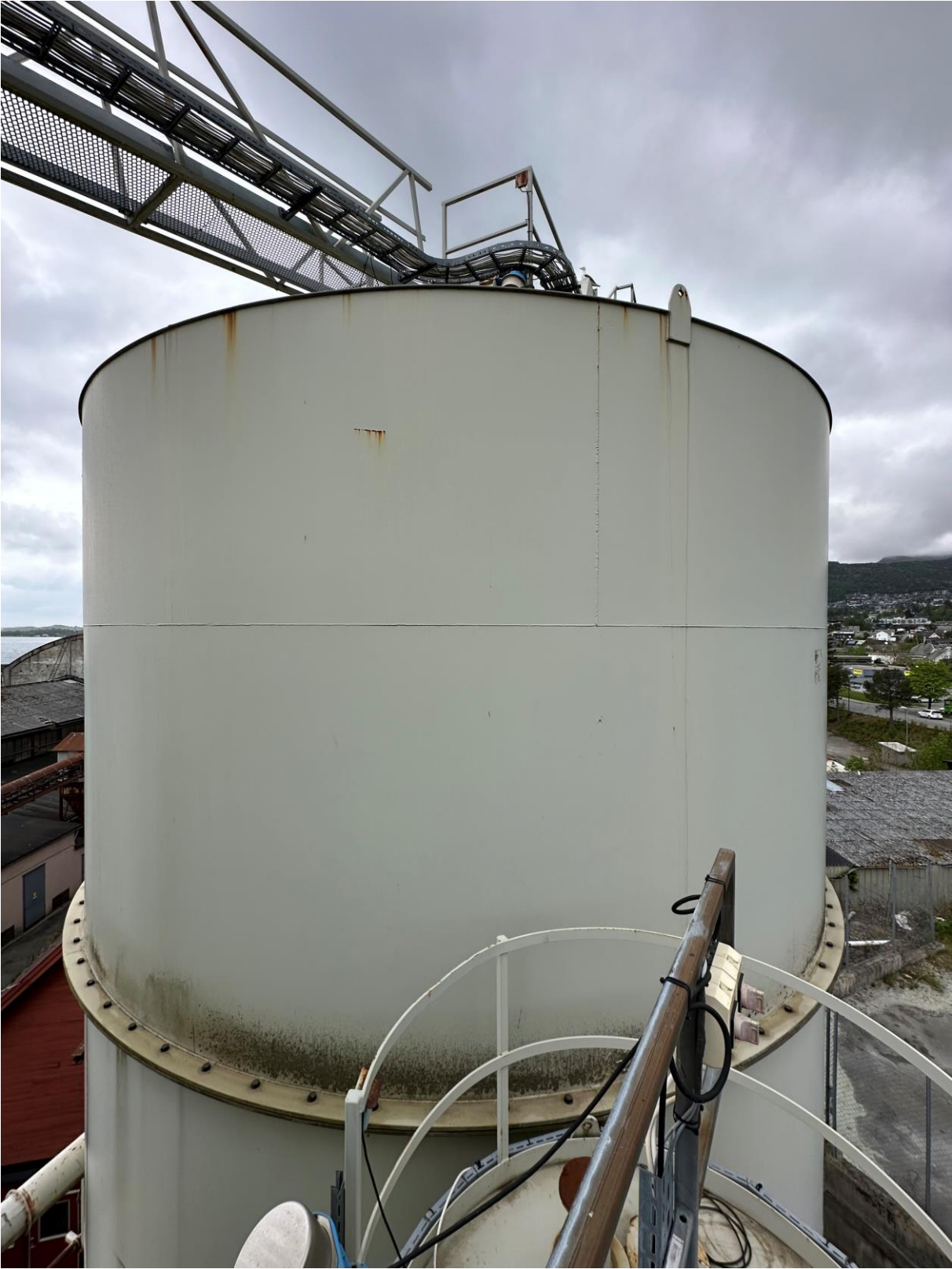
Silo top med løfte punkt. Broer med gangbane mellom alle siloene
